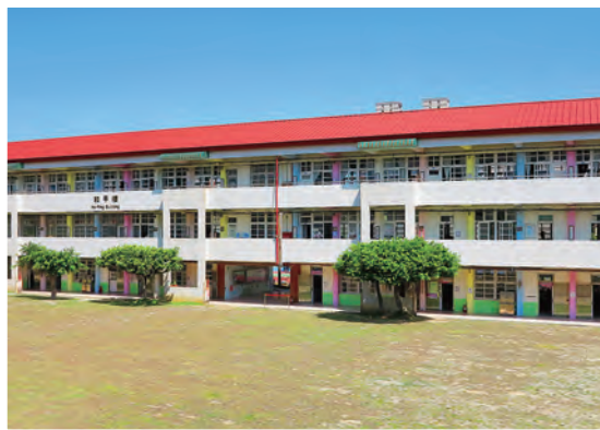
110年春改為綠草皮、增建防水屋頂
