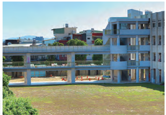
信義樓拆除，新設通廊、樓梯、 電梯及廁所，新的天際線
