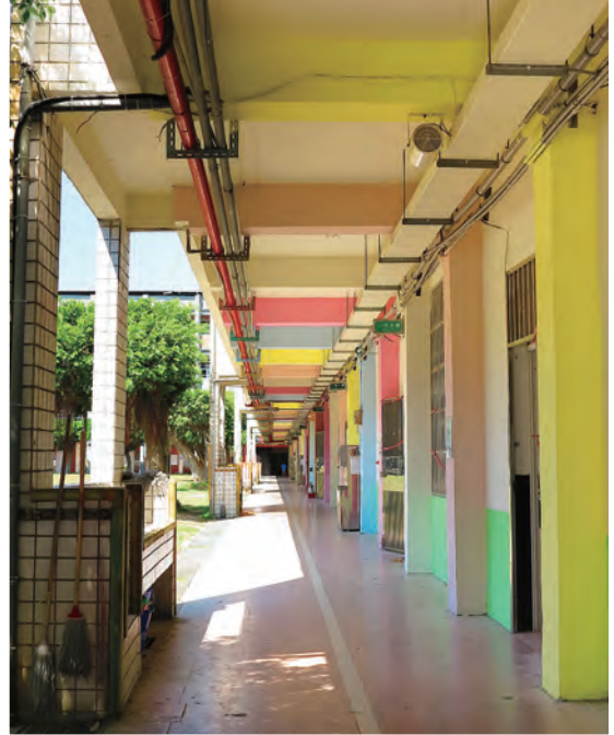
110年和平樓走廊，增設線槽及洗手臺
